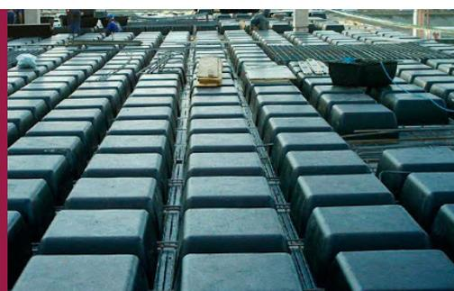
Forma em PVC, tipo Cubeta, de alta resistência para lajes nervuradas.
